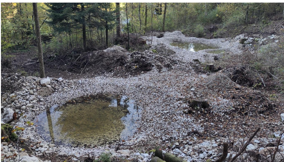
Diversification des niveaux d'eau et des structures par la réalisation de deux étangs sur le même site en 2024. © Alain Lugon
